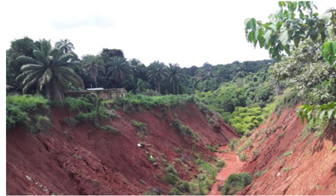
Nnewichi Erosion Site
